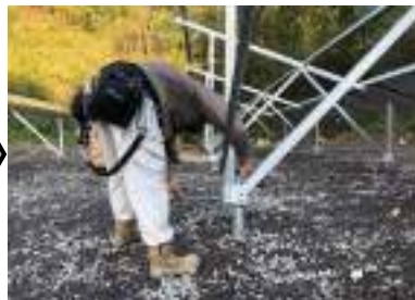
③架台組立工
