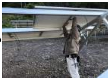
④パネル敷設
