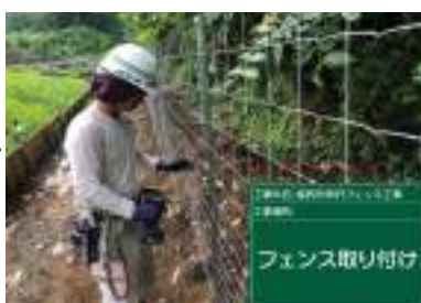
⑥フェンス設置工
