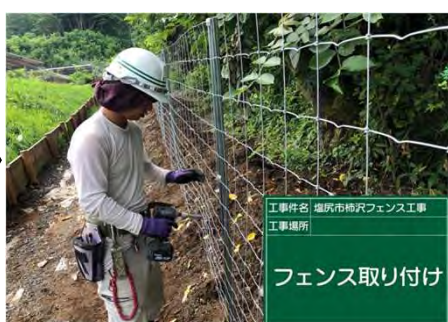
⑥フェンス設置工
