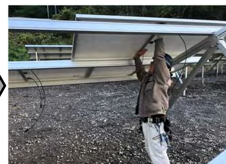
④パネル敷設
