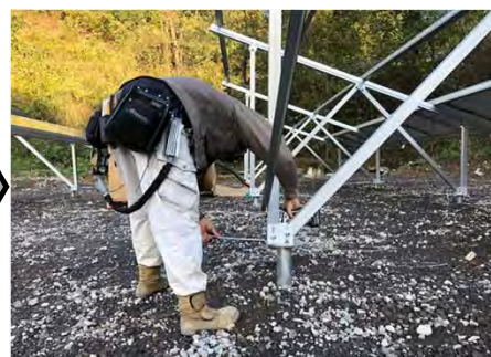
③架台組立工
