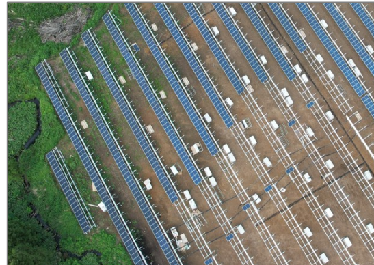
⑤パネル設置
