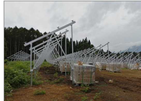
④架台設置
