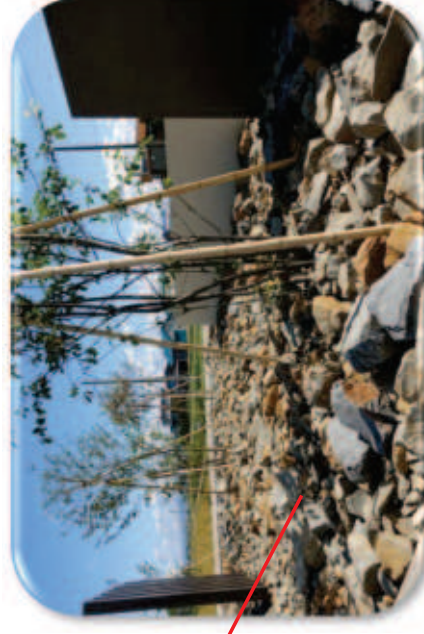
割栗石で 底面の浸透性を向上
