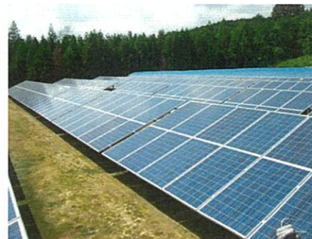
③架台にパネルを設置します。
