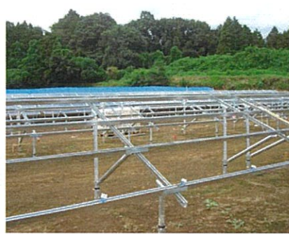
②基礎状に架台を組み立てます。
