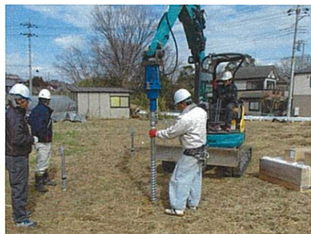
①基礎のスクリュー杭を埋設します。
