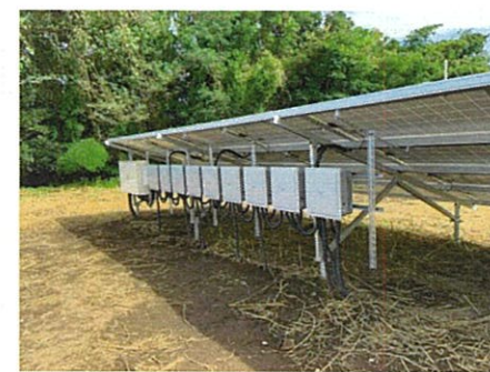
④パワーコンディショナーを設置します。
