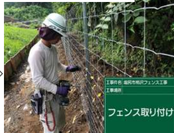
⑥フェンス設置工
