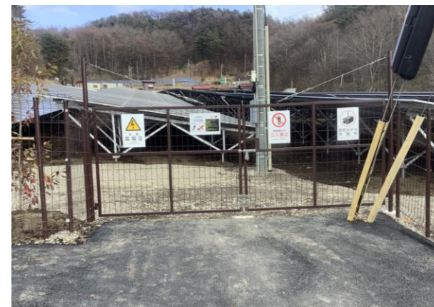
門扉／標識を取り付け
