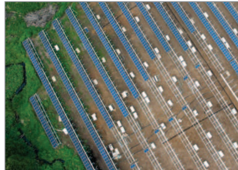
⑤パネル設置
