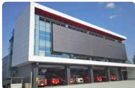
長野市消防局中央消防署 (長野市)
