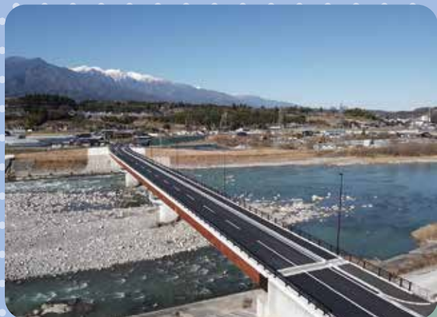
宮ヶ瀬橋（松川町）
