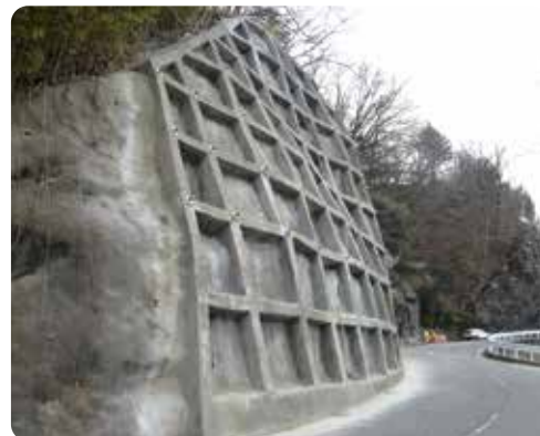
芝平高遠線 法面補修工事後（伊那市）
