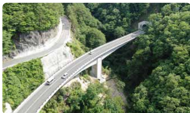
矢越トンネル・滝上大橋 (筑北村)
