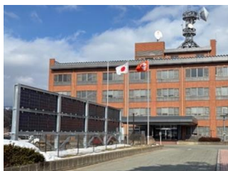
太陽光発電設備の導入
