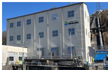
小水力発電所の設置
