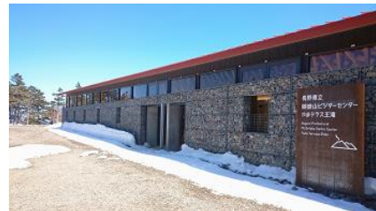
県有施設の新築
