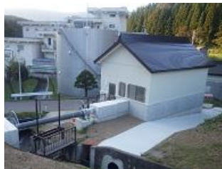
小水力発電所の設置
