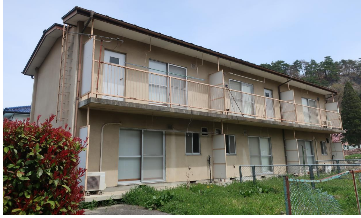
物件番号 1 (小山住宅)
