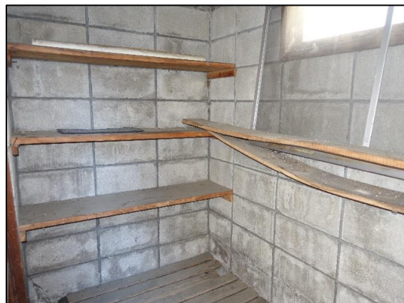
附属建物（内部）
