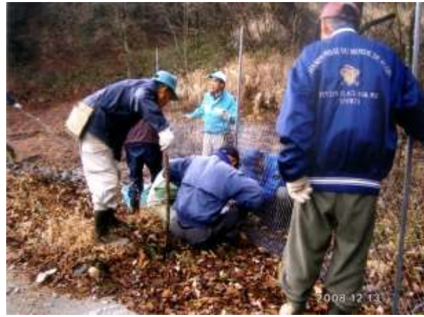
防護柵の見回り、補修
