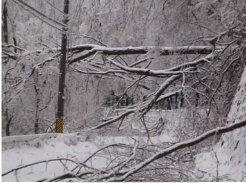
国道142号の倒木状況
