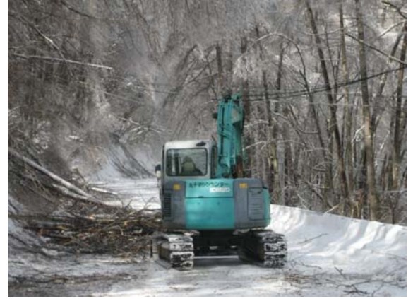
地元建設業者による復旧作業状況(美ヶ原公園沖線)
