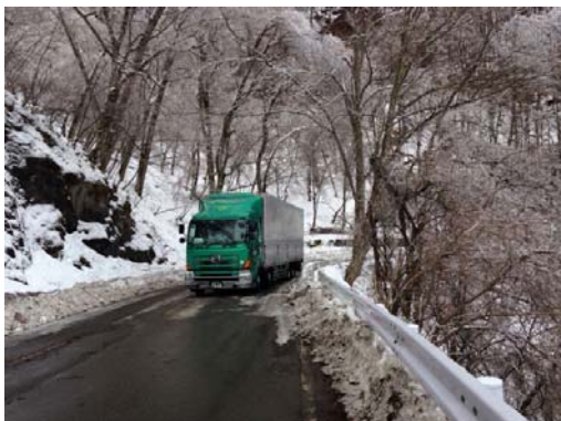
復旧後の通行状況(国道142号)
