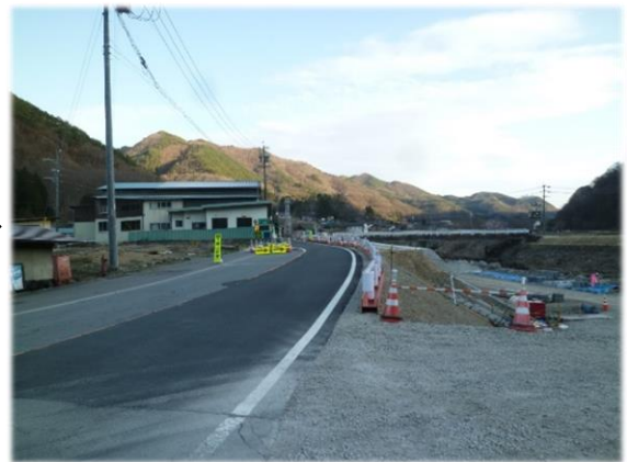
■ 復旧状況 (令和 2 年 4 月 14 日)
