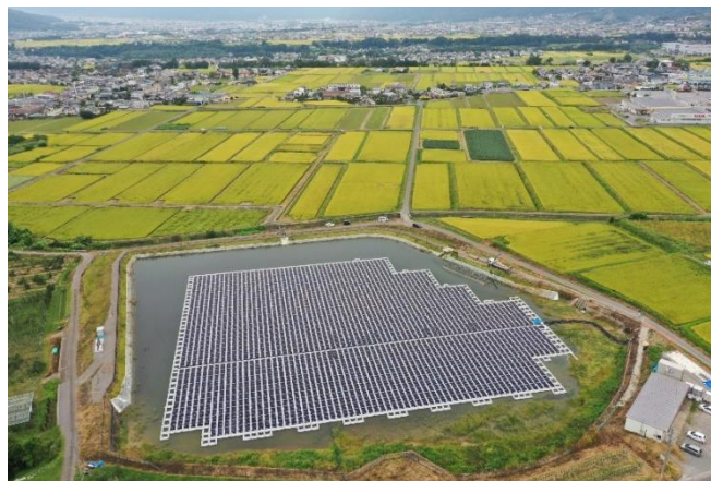
農業用ため池を活用した太陽光発電施設(上田市)
