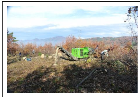
【遊歩道の整備】
