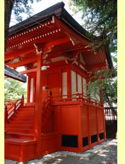
生島足島神社摂社諏訪社本殿及びび門
