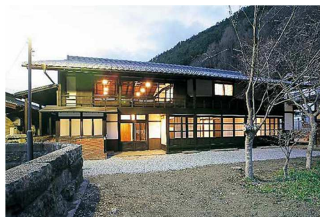
空き家の活用
