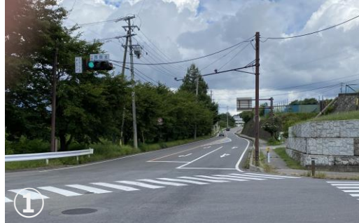
②市道0119号線 幅員：8.0m 歩道・縁石あり（うち歩道1.5m）
