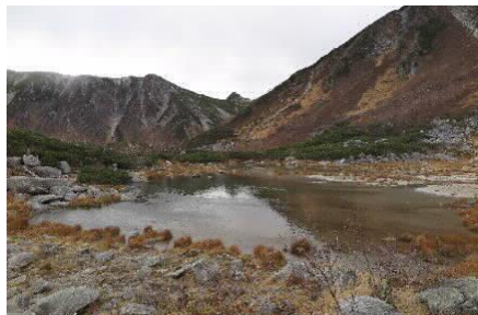
2021年10月上旬撮影(保全工事試工後)
