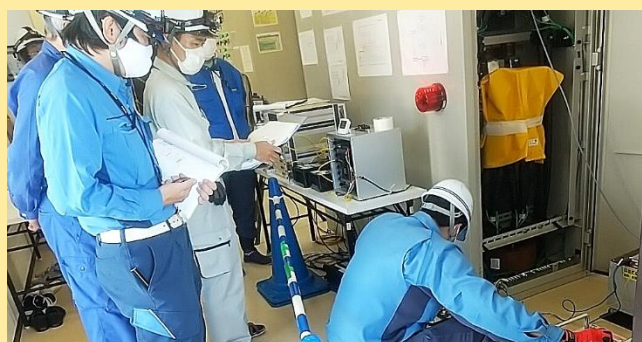
使用前自主検査の状況
