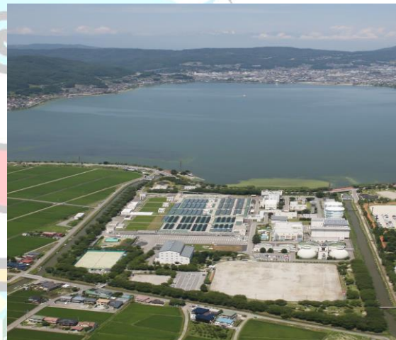
現在の処理場
