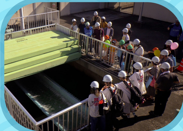
処理場見学 (3 過水槽)
