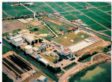
平成4年6月、水処理1系列の一部供用開始及び放流管建設中の状況。鴨池川の対岸は放流管の製作ヤードです。
