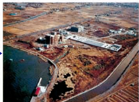
昭和52年、武井田川の付け替えが完了し、管理本館、水処理3系列、ブローア棟、汚泥処理棟、沈砂池ポンプ棟の建設が進んでいます。
