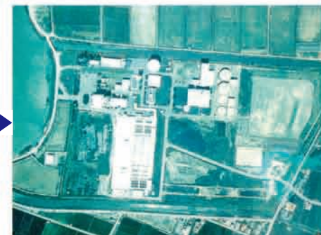
昭和58年6月、水処理2系列機械設備工事及び1号焼却炉棟完成時の状況。
