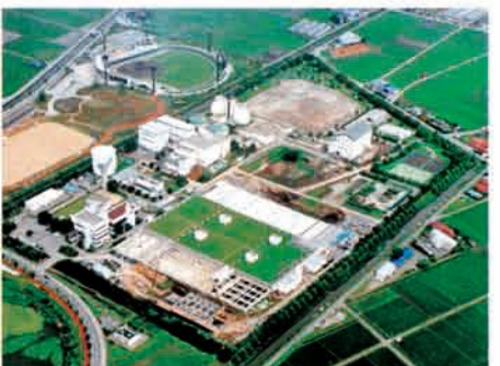
平成10年、高度処理の導入に伴う砂ろ過施設などの建設工事が着々と進んでいます。
