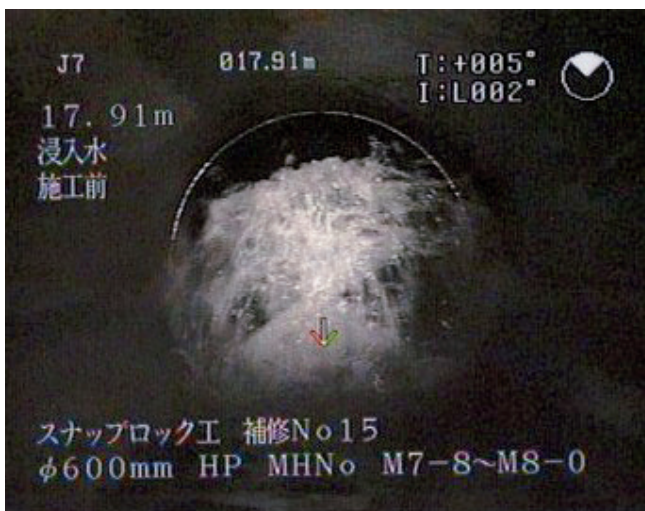
地下水浸入個所の補修状況(施工前)
