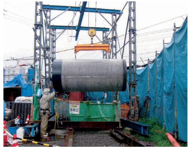
推進工法の発進立坑
