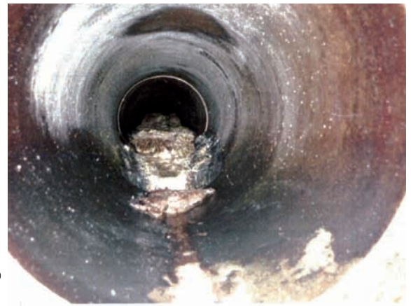
管路のロボットカメラによる調査
