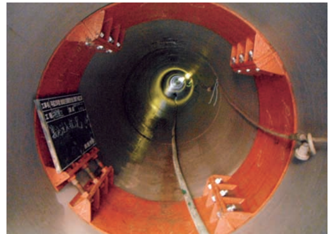
掘削後の状態
