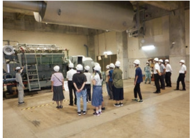
非常用発電設備
