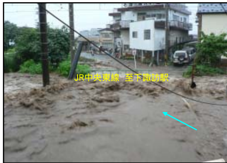
JR中央東線の冠水状況(B)
