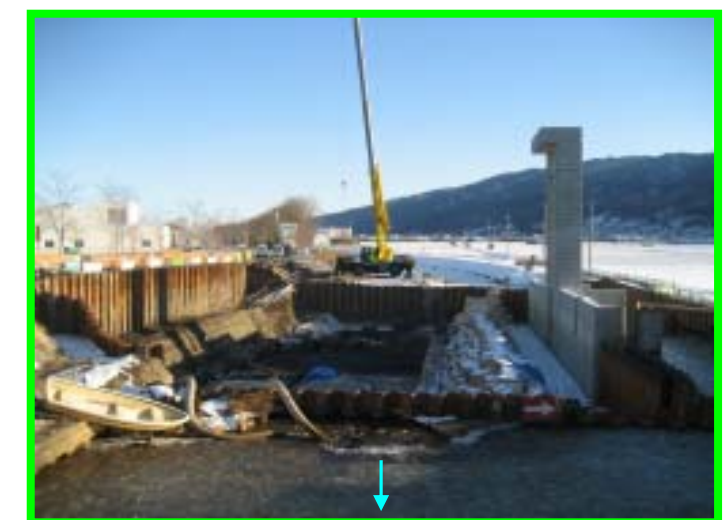
武井田川水門本体工の施工状況(右岸側底板部を施工中)H21.1.15撮影
