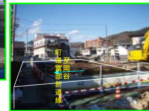
掘削に着手した町道富部新道線のボックスカルバート工事
