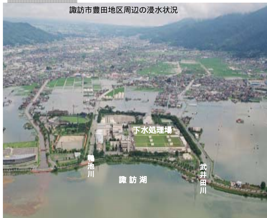
被害状況写真
