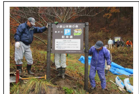
【看板設置作業の様子】
