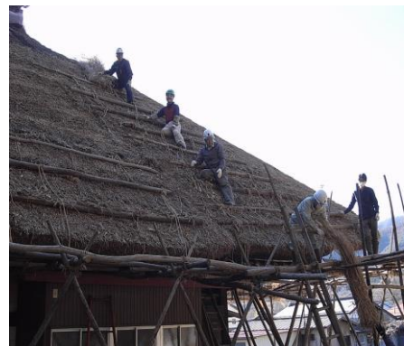
【茅葺作業の様子】
