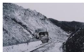
土砂崩落の状況
