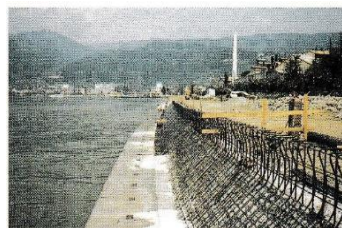
波返しコンクリート施工写真
