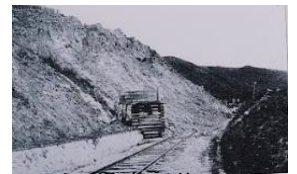
土砂崩落の状況
