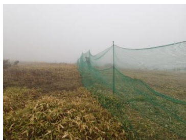
防護柵設置状況
