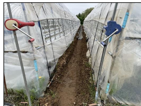
写真 42 ハウス間明渠の様子
