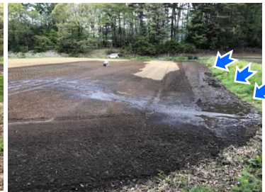
写真19 法尻の過湿状況 <矢印赤方向から撮影>
