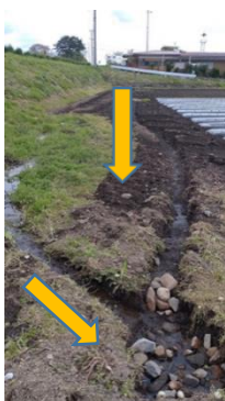
写真17 明渠の設置
