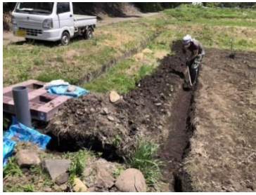
写真 24 明渠床掘り（左）、レベルによる勾配確認（中）北側水路掘削完了（右）
