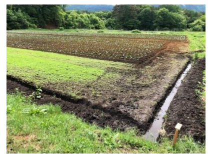
写真 26 南側水路の追加（写真左）、法尻水路の排水路への接続（写真中央、右）
