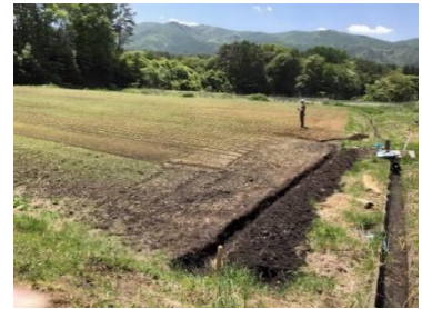
写真 24 明渠床掘り（左）、レベルによる勾配確認（中）北側水路掘削完了（右）
