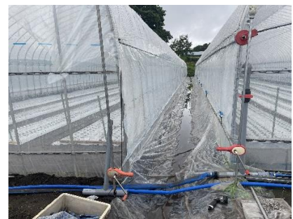
写真9 ハウス間の不透水性シート
