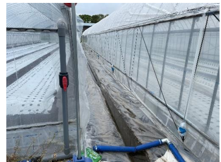
写真 38 降雨後のハウス間の様子
