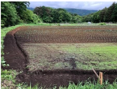
写真 26 南側水路の追加（写真左）、法尻水路の排水路への接続（写真中央、右）
