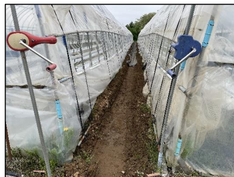
写真 42 ハウス間明渠の様子
