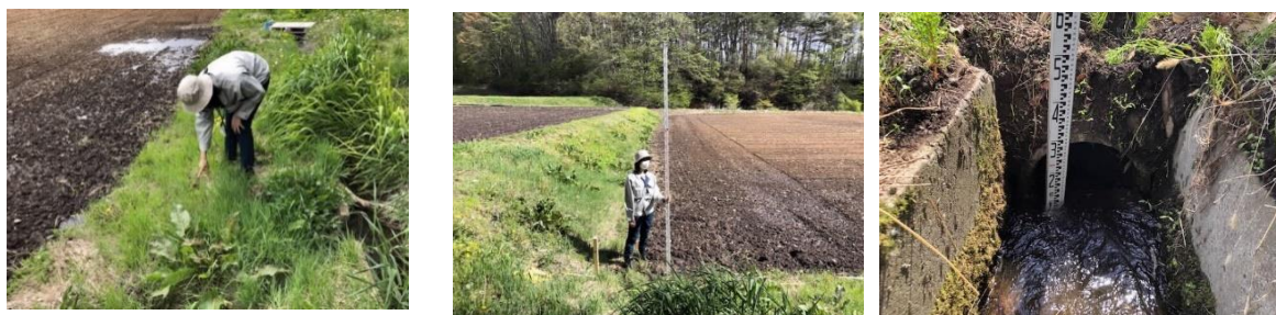
写真 21 かけ口(跡)からの流入 写真 22 レベルを用いたほ場の起伏と流末候補の測量
