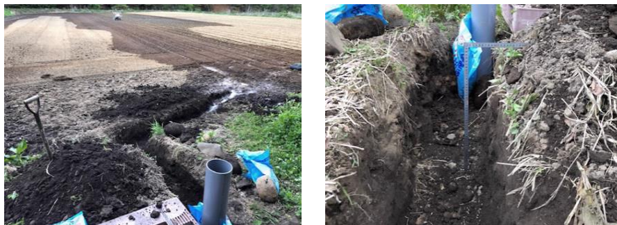
写真 23 流末の確保 スムーズな排水のため、流末付近は 50 cm以上の掘削を実施
