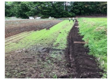
写真 25 農家への作業機（YK300RK、片寄ローター）の説明（写真左） 対象農家による溝掘り作業（写真中央）、丁張による勾配確認（写真右）
