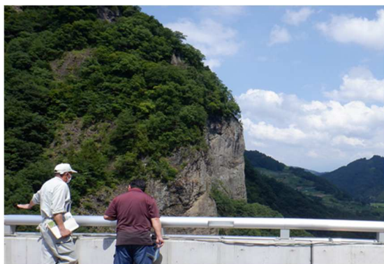
裾花ダムの堤頂見学の様子
