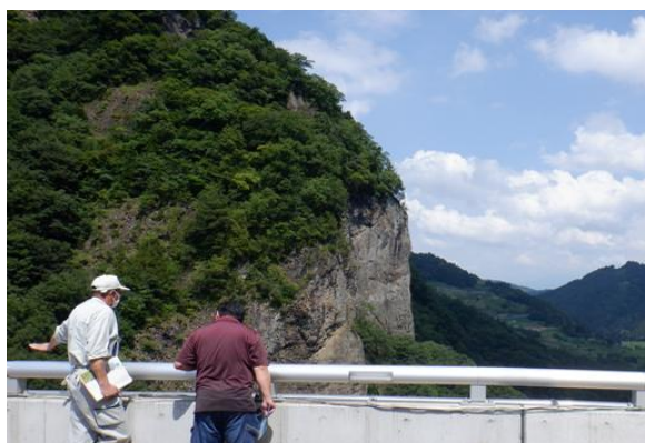
裾花ダムの堤頂見学の様子
