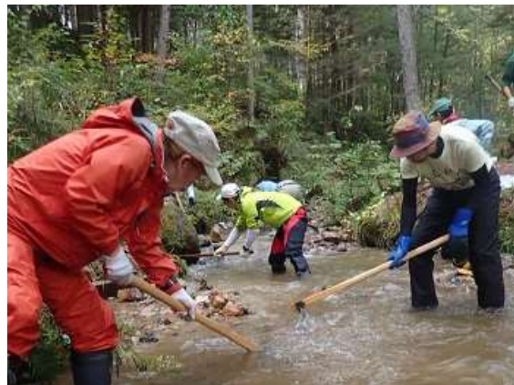
写真1 川底の掘り下げ作業
