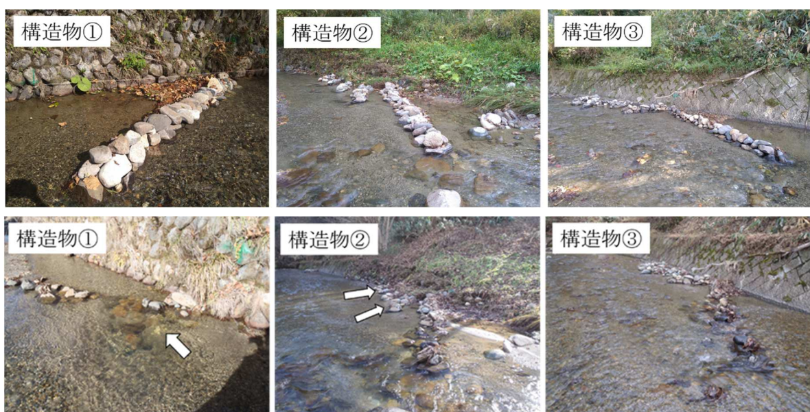
図 3 造成後の人工構造物の様子
