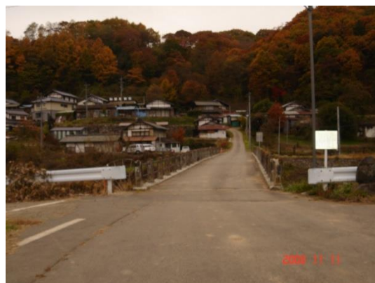
4 宮玉の井橋を右岸側から見る
