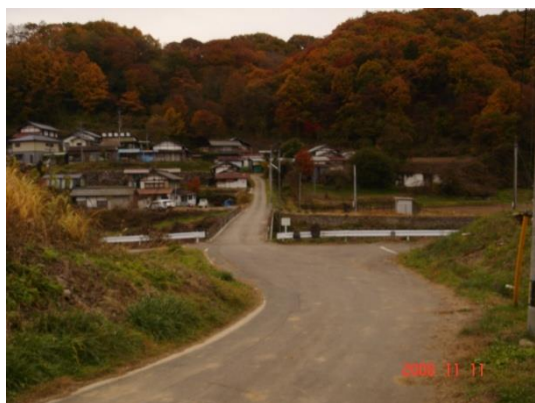
3 宮玉の井橋を右岸側から見る
