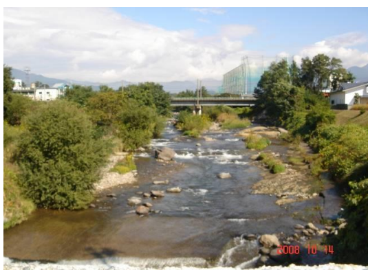
神川橋 上流側
