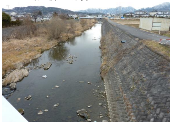
堀川橋 上流側
