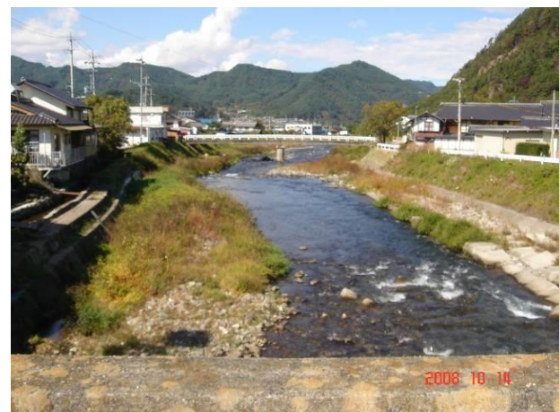
立岩上の橋 下流側
