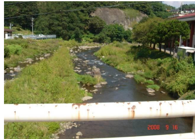
前田橋 下流側
