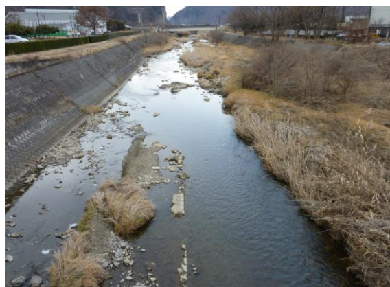
堀川橋 下流側
