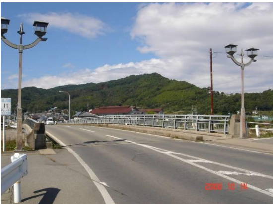
依田橋 右岸側
