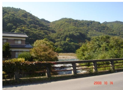
神川橋 下流側
