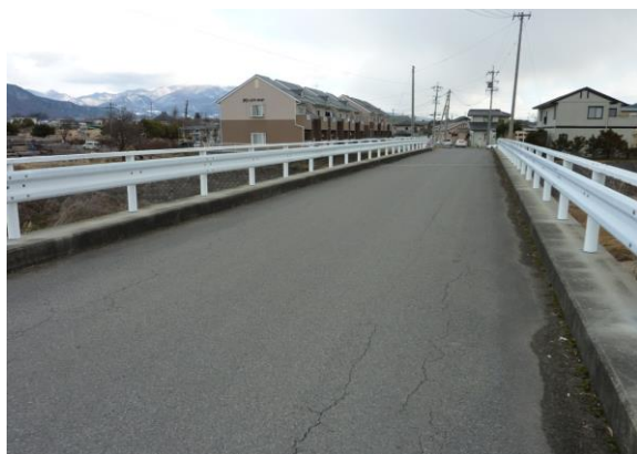
堀川橋 左岸側から
