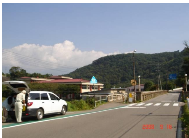
前田橋 左岸側
