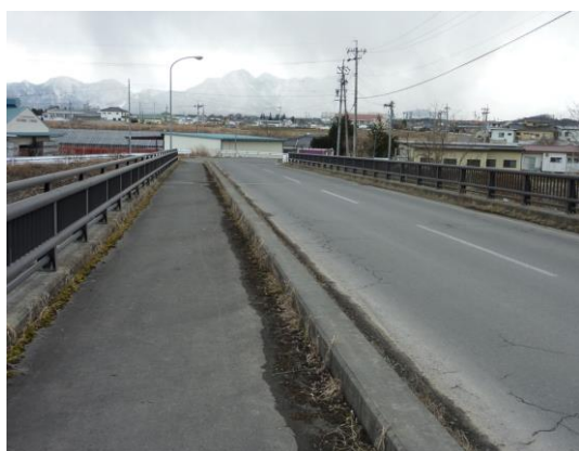
八幡橋 左岸側から
