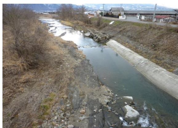
八幡橋 下流側
