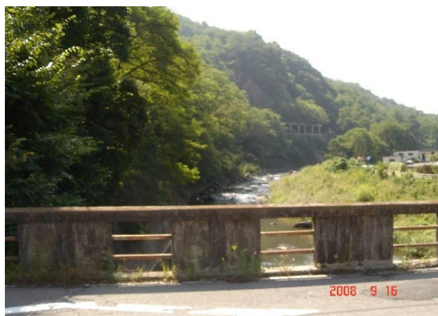
前田橋 上流側
