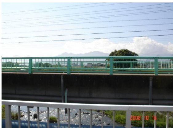
対影橋 上流側
