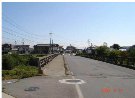
神川橋 右岸側
