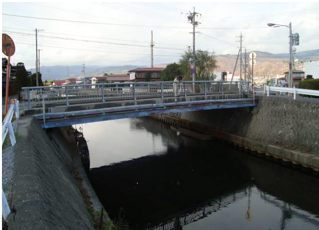
宮川橋 上流側から
