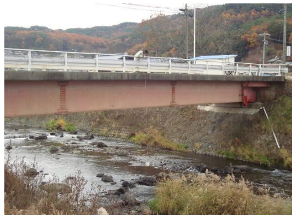
西茅野大橋 右岸から
