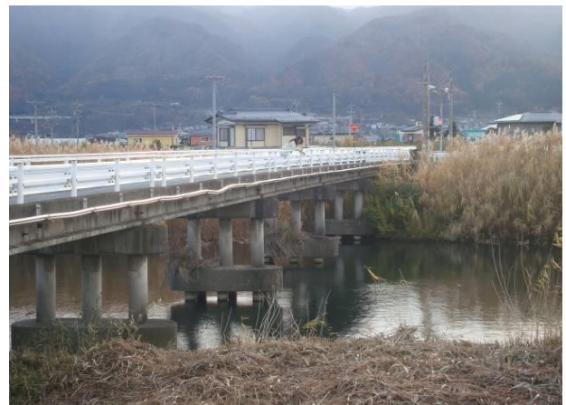
洪崎橋 右岸から
