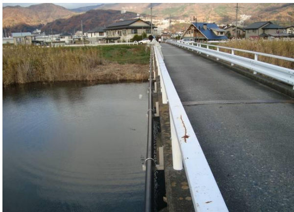
洪崎橋 左岸から
