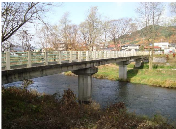
矢ヶ崎橋 上流側から
