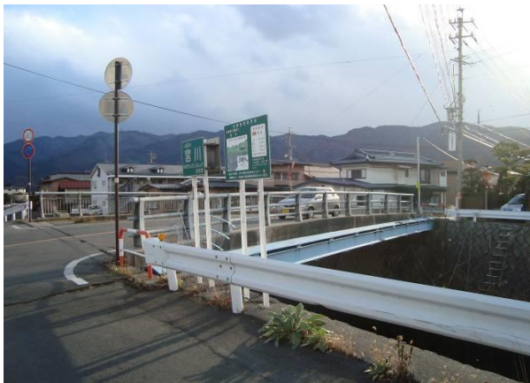
宮川橋 下流側から
