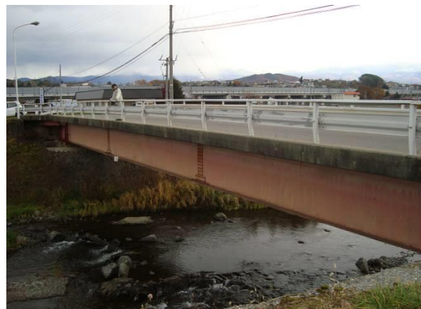
西茅野大橋 左岸から
