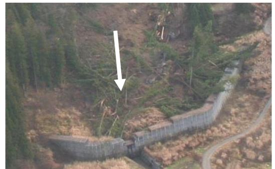
【神城断層地震発生時に流出した土砂を捉えた砂防堰堤】
