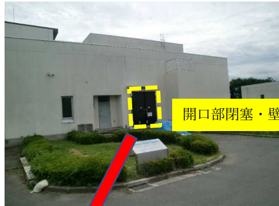
(放流ポンプ棟耐水化)
