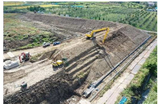
<ため池の防災工事>
