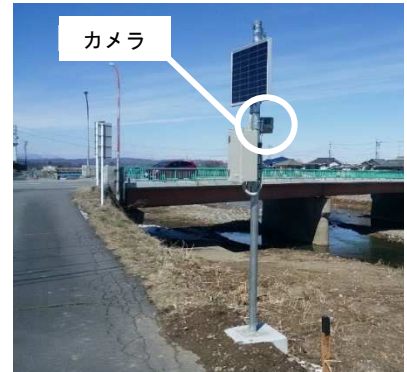
(一級河川滑津川 佐久市滑津橋)
